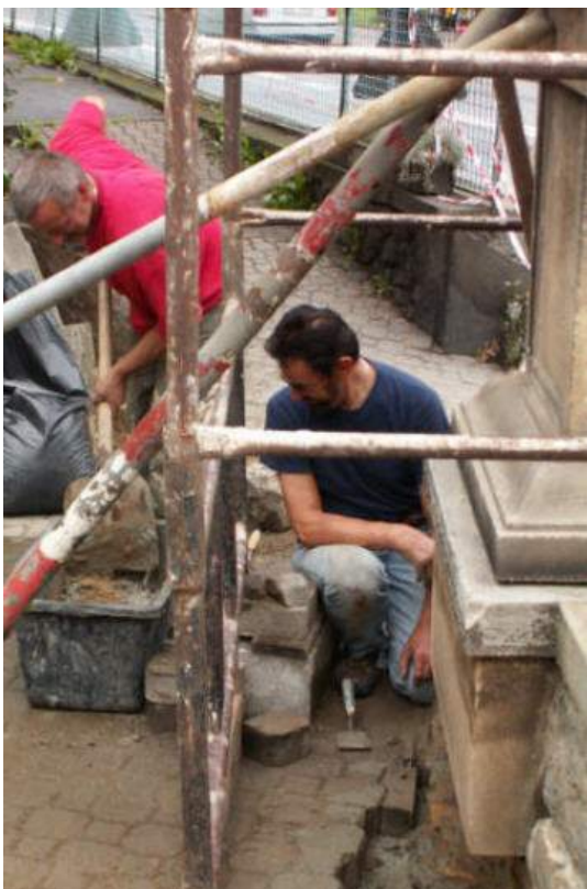
Abb. 16: Restaurierung des Fundaments
