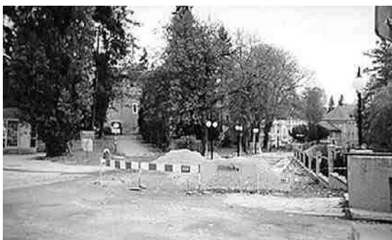
Die Bauarbeiten ab Magdabücke sind in vollem Gange. (Oktober 1999)
