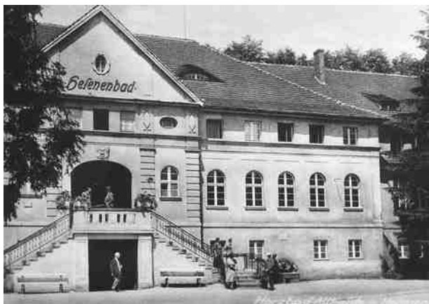
So soll es wieder werden
