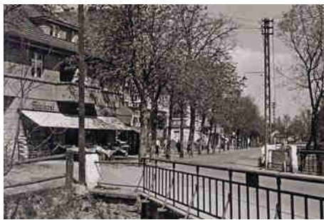
Weistritzbrücke bei „Feinkost-Thaler“
