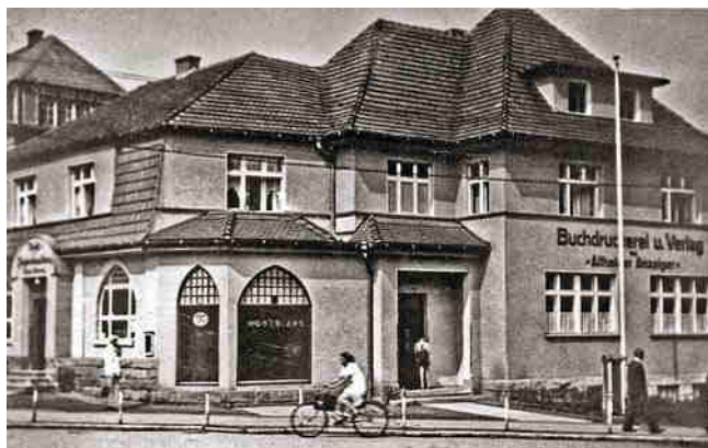
Buchhandlung und Druckerei nach dem Umbau
