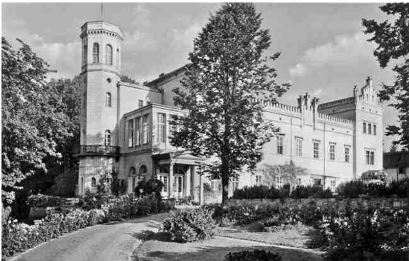
Schloss Wallisfurth nach dem Umbau
