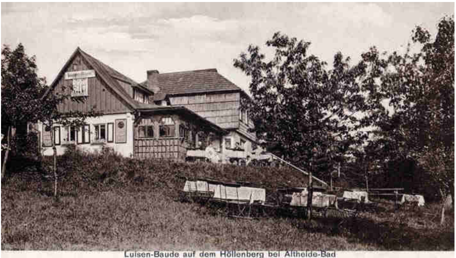
Luise-Bau auf dem Hölleberg bei Altheide-Bad
