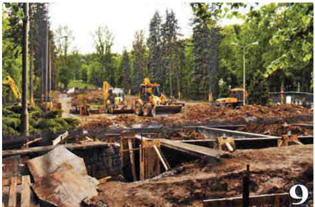
Die Baustelle am Zedlitz-Park
