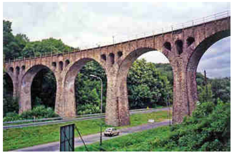
Eisenbahnbrücke bei Lewin
