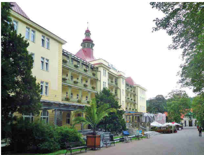
Das umgestaltete Kurhaus im August 2011, an der Terrasse wird noch gearbeitet
