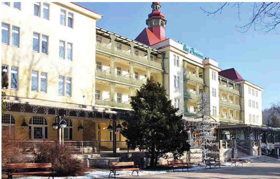
Bild 7. Die offene Terrasse links vom Haupteingang 2012
