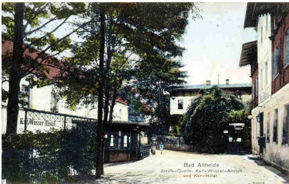
Links das Brunnenhäuschen des Josefsbrunnenes
