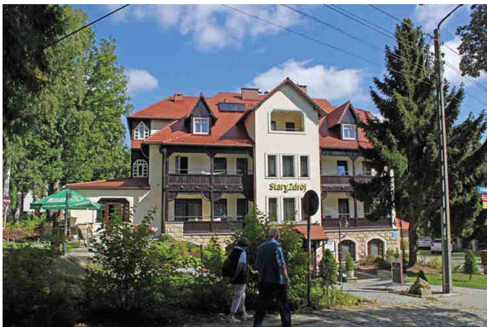
Das Haus Leopoldshöh an der Bergstraße in Neuheide ist wiederbelebt worden und heißt jetzt: „Stary Zdrój“
