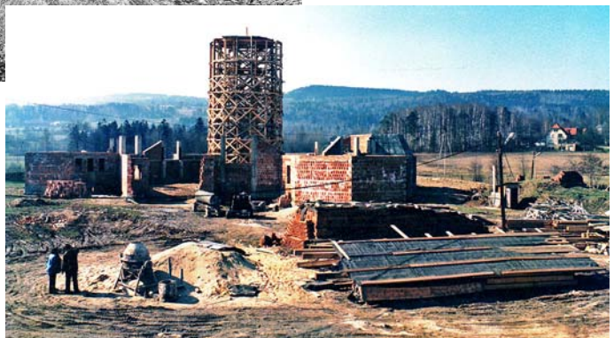
Aufbau der Kirche, im Hintergrund der Behelfsturm für die Dachkonstruktion
