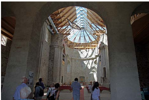
Die Wallfahrtskirche „Maria Himmelfahrt“ in Bärnwald/Neratow. Der Dachgiebel ist verglast, die Außen- und Innenwände des Kirchenschiffs sind nicht verputzt, sondern nur verfugt.
