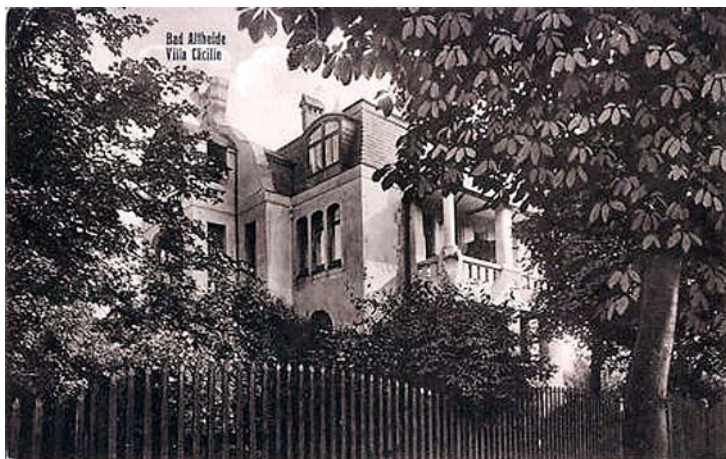
Villa Caecilie 1932 an der Heuscheu- erstraße bei der Schule.
